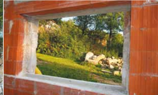
Doublement des murs en pierre avec des briques alvéolées en terre cuite de 200 mm.
