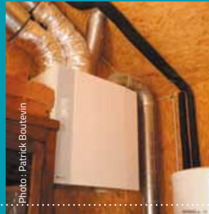
Photo : Patrick Boutevin La VMC double-flux préchauffe l'air entrant en puisant les calories dans l'air extrait.
