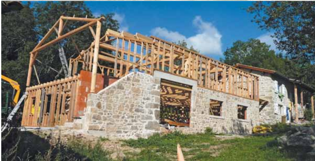
Doublement des murs en pierre avec des briques alvéolées en terre cuite de 200 mm.
