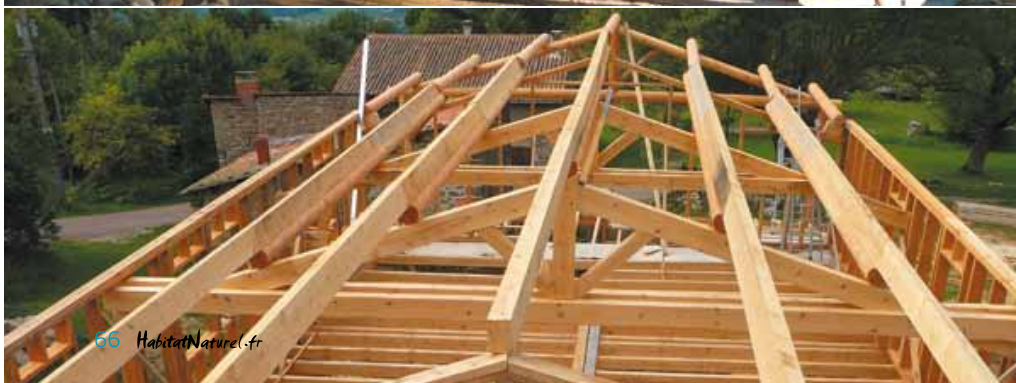
La charpente du nouveau toit.
