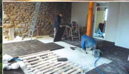
Janvier 2012 : des panneaux de liège de 60 mm sont posés au sol par dessus la dalle.
