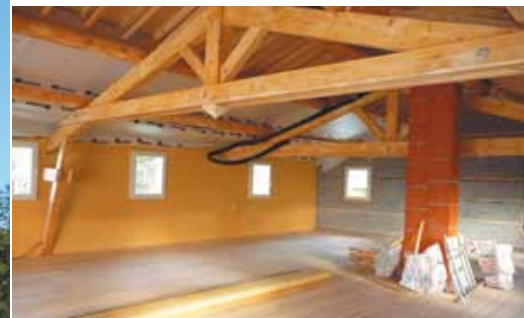
A droite, on aperçoit l'isolation en ouate de cellulose projetée entre montants d'ossature.
